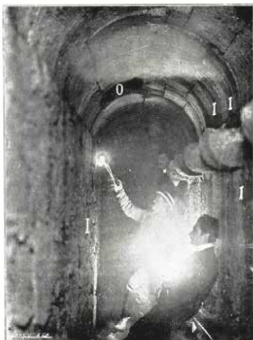
Fig. n.º 59 — Manancial da Cavaca. O oculo proximo do cotovello em que as infiltrações são abundantissimas correspondendo exteriormente ao ponto representado na figura seguinte.
