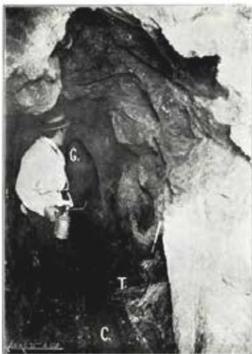
Fig. n.º 61 — Manancial da Cavaca. G., Entrada da gruta; T., Telha que recebe choros diferentes que se lançam na caleira C.
